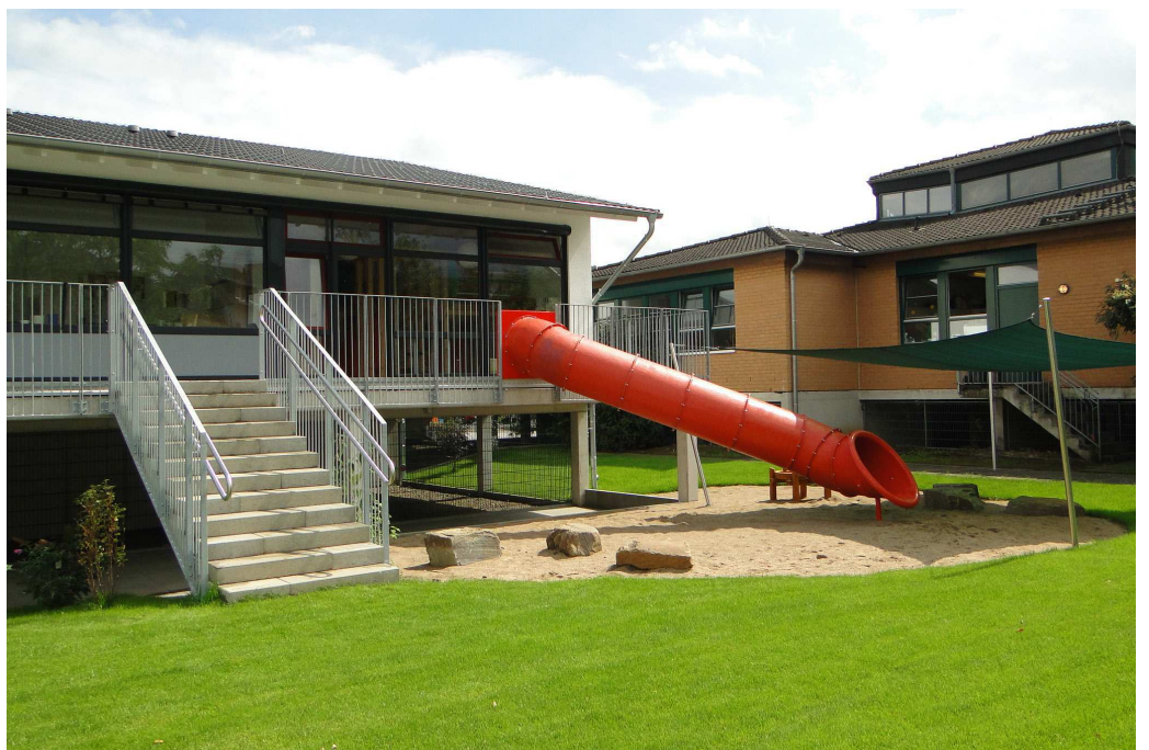
Außentreppe mit Hutsche
